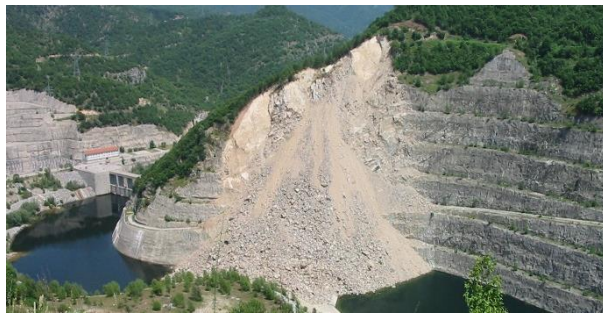
Φωτ. 4.3.2 Βραχολίσθηση σε δεξιό αντέρεισμα του Φράγματος
