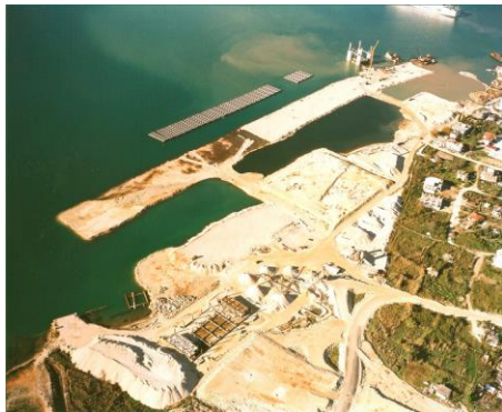
Φωτ. 6.1.1 Απόψη του Νέου Λιμένα Ηγουμενίτσας (φάση κατασκευής)
