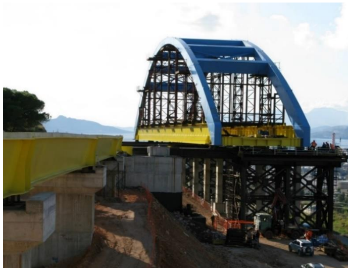
Φωτ. 9.2.1 Γέφυρα Σ/Γ πάνω από την κατολίσθηση σε φάση κατασκευής
