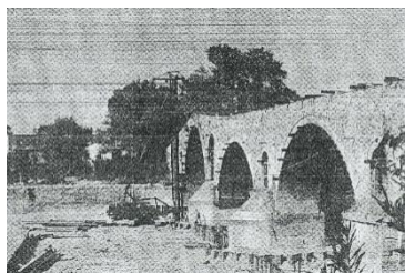
Φωτ. 2.2.1 Παλιά Γέφυρα Άρτας
