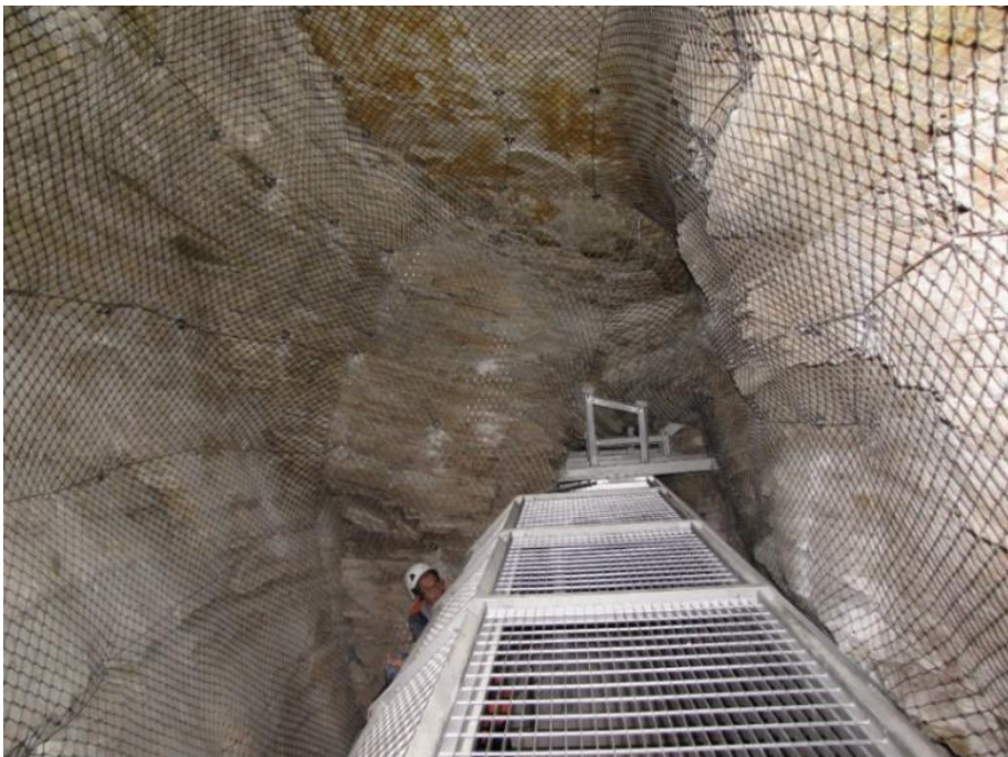
Φωτ. 2.1.1 Μέτρα υποστήριξης
