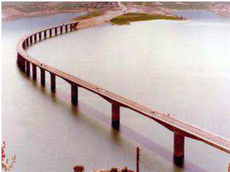
Φωτ. 5.2.1 Όψη της Γέφυρας των Σερβίων
