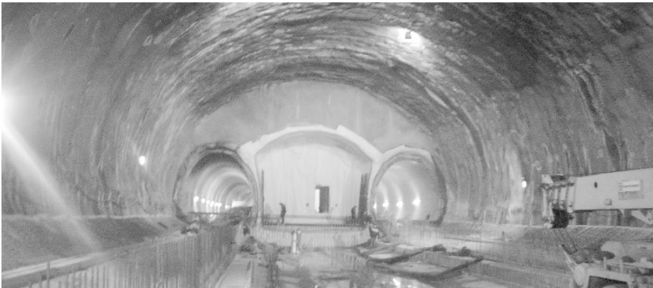
Φωτ. 3.4.1 και 3.4.2 Φάσεις από την κατασκευή της Υπόγειας Caverna του Σταθμού Μετρό Αιγάλεω
