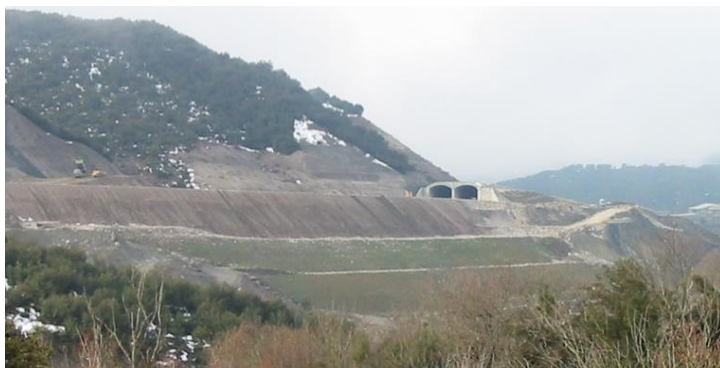
Φωτ. 8.3.1 Άποψη του Οπλισμένου Επιχώματος της Εγνατίας Οδού. Στο βάθος διακρίνεται το cut and cover Σ1
