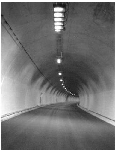
Φωτ. 3.3.2 Εσωτερικό κατασκευασμένης σήραγγας περιοχής Αγ. Κωνσταντίνου
