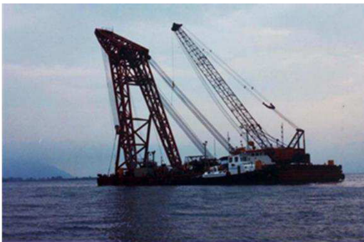
Φωτ.6.2.1 Πλωτό Γεωτρήπανο
