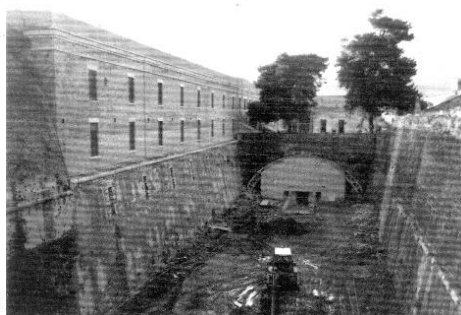
Φωτ. 2.4.1 Φάση εργασιών ενίσχυσης εδάφους θεμελίωσης στους Στρατώνες Κέρκυρας
