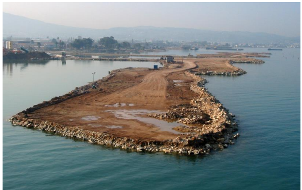
Φωτ. 6.1.2 Κατασκευαζόμενο επίχωμα προφορτίσεως σε Νέο Λιμένα Πατρών
