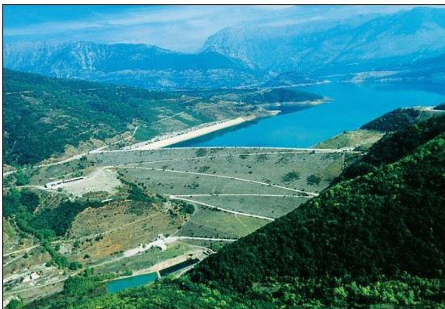
Φωτ. 4.1.1 Απόψη του Φράγματος του Μόρνου
