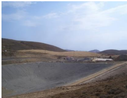
Φωτ. 10.2 Κατασκευή Κεντρικού Χ.Υ.Τ.Α. Νήσου Λήμνου
