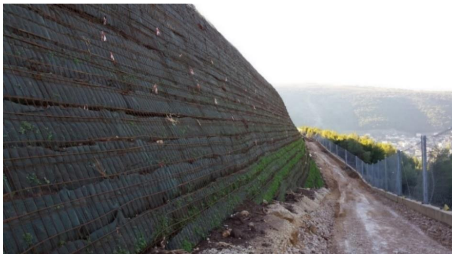
Φωτ. 8.2.1 Όψη του Οπλισμένου Επιχώματος με εμφανή την τεχνική περιτύλιξης των οπλισμών
