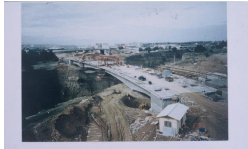
Φωτ. 2.5.2 Η νέα οδική γέφυρα σε φάση κατασκευής
