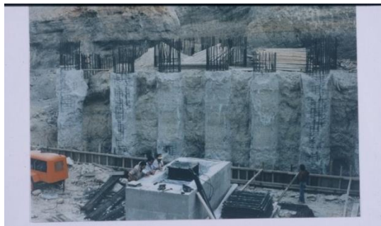
Φωτ. 2.5.3 Τοποθέτηση εφεδράνου σεισμικής μόνωσης
