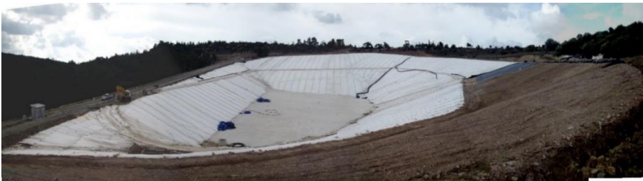
Φωτ. 10.1 Κατασκευή Κεντρικού Χ.Υ.Τ.Α. Νήσου Λήμνου
