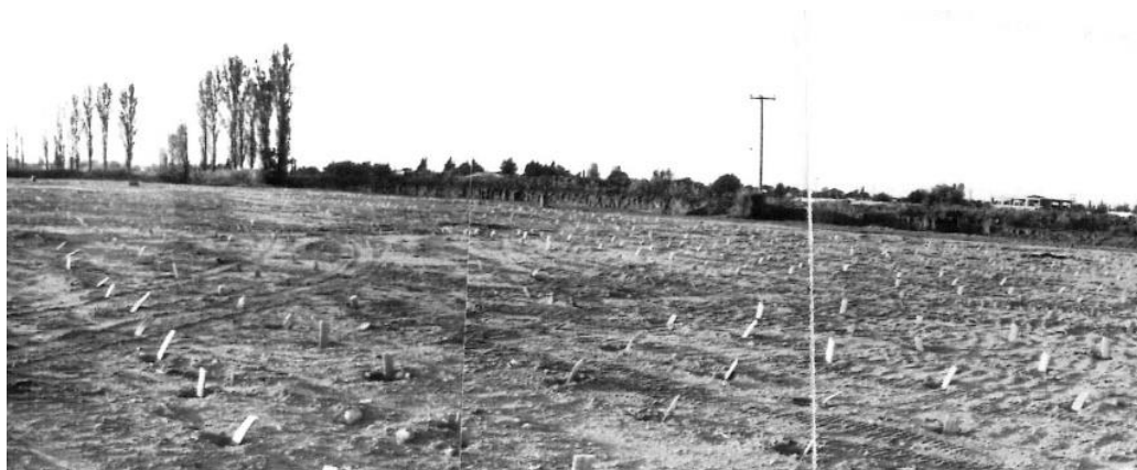
Φωτ. 11.2.1 Προφόρτιση με στραγγιστήρια για το Στάδιο Θέρμης
