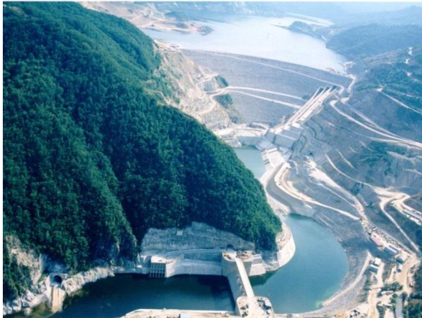
Φωτ. 4.3.1 Το Φράγμα Θησαυρού
