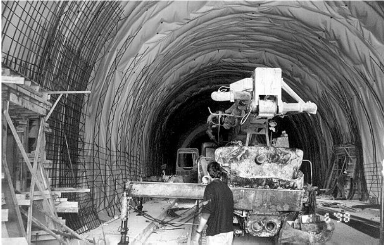
Φωτ. 3.2.1 Σήραγγα Τεμπών στη φάση κατασκευής
