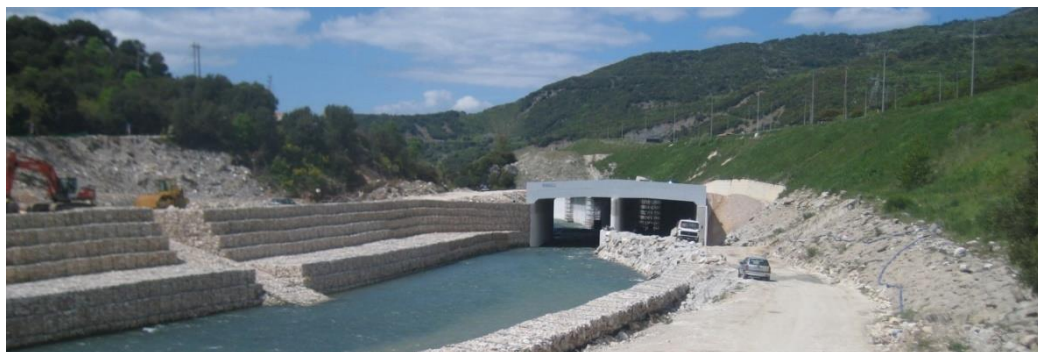
Φωτ. 9.1.1 Τεχνικό κάλυψης Ποταμού Μετσοβίτικου στο Τμήμα 2.4 της Εγνατίας Οδού προς σταθεροποίηση των κατολισθήσεων διά του αντιβάρου που συνιστά η επίχωση του τεχνικού αυτού. Στιγμιότυπο από την κατασκευή με το ρου του ποταμού προσωρινά εκτραπέντα εντός του ενός φατνώματος του τεχνικού (αριστερά = νότιο φάνωμα) για την κατασκευή του άλλου φατνώματος
