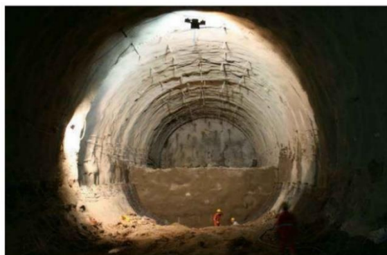
Φωτ. 3.1.2 Όψη δύσκαμπτης και διαρρέουσας υποστήριξης κατά τη φάση κατασκευής της σήραγγας
