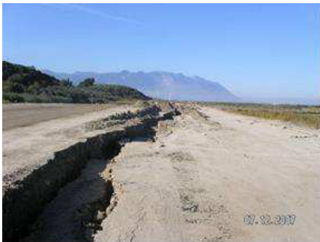
Φωτ. 8.1.1 Ρωγμή και Καθίζηση
