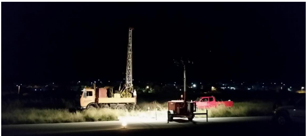
Φωτ. 7.2.2 Γεωτρύπανο κατά τη διάνοιξη γεώτρησης δίπλα από διάδρομο αποπροσγείωσης αεροσκαφών τη νύχτα για να μην υπάρχει κίνηση αεροσκαφών
