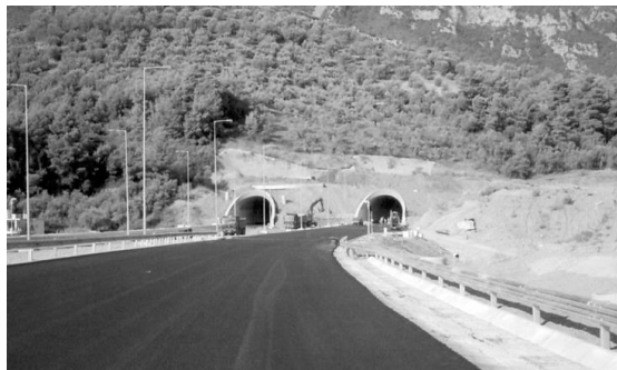
Φωτ. 3.3.1 Είσοδος δίδυμων σηράγγων περιοχής Αγ. Κωνσταντίνου
