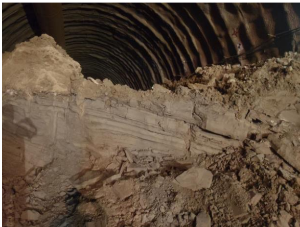
Σχήμα 3. Άποψη μάργας σε βαθμίδα εκσκαφής & θέση εκτέλεσης οριζόντιας γεώτρησης. Figure 3. View of the marl on an excavated bench face and location of horizontal drilling.
