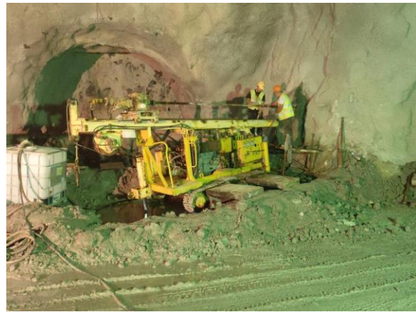
Σχήμα 3. Άποψη μάργας σε βαθμίδα εκσκαφής & θέση εκτέλεσης οριζόντιας γεώτρησης. Figure 3. View of the marl on an excavated bench face and location of horizontal drilling.
