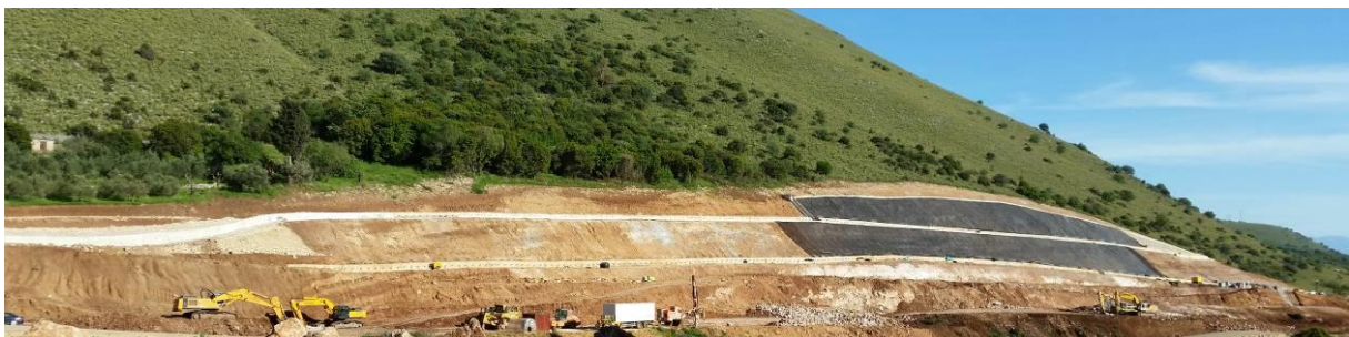
Σχήμα 2. Αποψη του ορύγματος κατά τη φάση της κατασκευής Figure 2. View of the cut slope during construction
