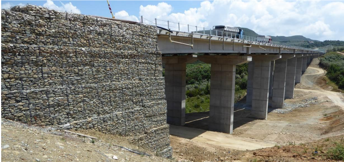
Φωτογραφία 1. Γέφυρα Μενιδίου και τοίχος οπλισμένου εδάφους όπισθεν ακροβάθρου A1 Photograph 1. View of Menidi Bridge and of reinforced soil wall behind abutment A1.
