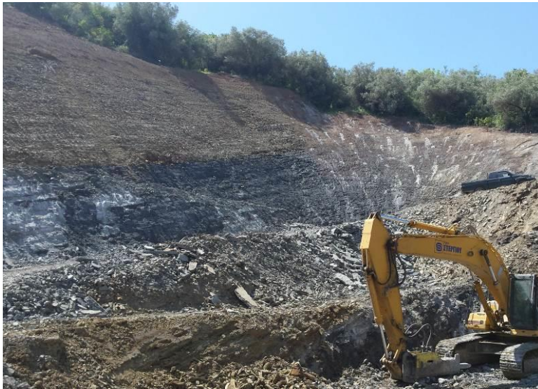
Σχήμα 4. Εκσκαφές θεμελίωσης τοίχου οπλισμένου εδάφους όπισθεν ακροβάθρου Α1 Figure 4. Excavations for the foundation of the reinforced soil walls behind abutment A1
