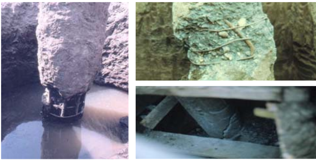
Φωτογραφία 1. Κατασκευαστικά ελαττώματα πασσάλων
