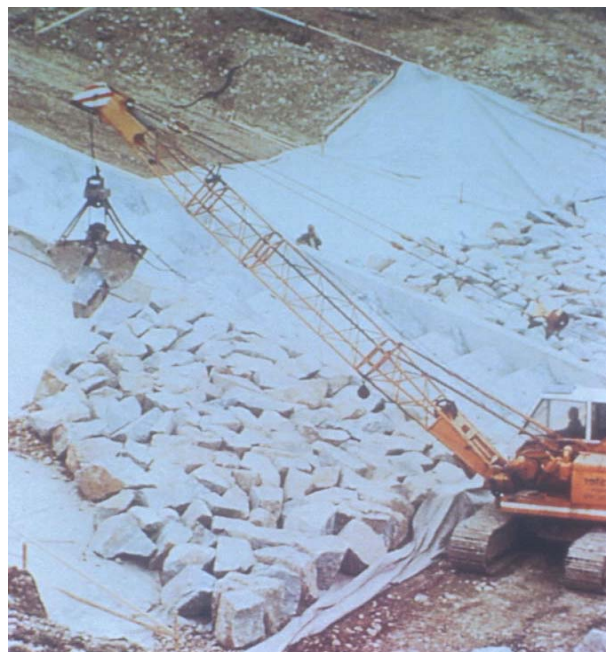
Φωτογραφία 19. Μόνιμη αντιδιαβρωτική προστασία με χρήση λιθορριπής τοποθετούμενης επί γεωυφάσματος Photograph 19. Permanent erosion control measures using stone riprap on a geotextile.
