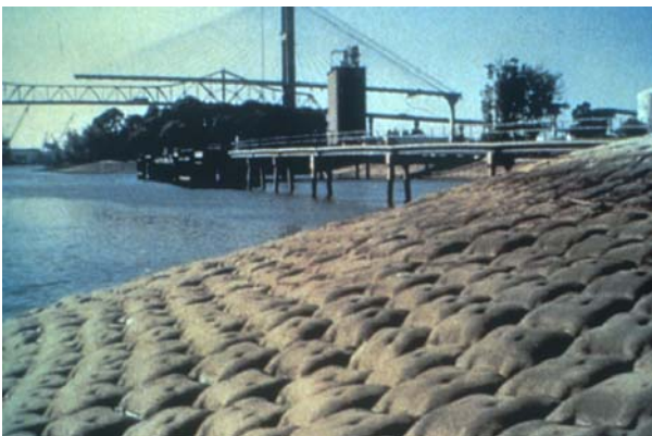
Φωτογραφία 21. Μόνιμη αντιδιαβρωτική προστασία όχθης ποταμού με ζεύγος γεωφασμάτων πληρωμένων ενδιάμεσα με σκυροδέμα Photograph 21. Permanent erosion control measures on riverbank using a pair of geotextiles filled in between with lean concrete.
