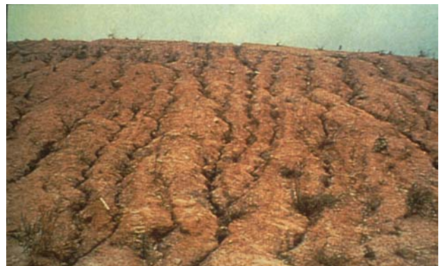
Φωτογραφία 3. Αυλακωτή διάβρωση πρανών. Photograph 3. Rill slope erosion
