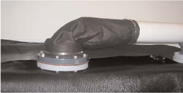
Φωτογραφία 24. Γεωσωλήνας: α) διαδικασία υδραυλικής πλήρωσης β) Στόμιο εισόδου. Photograph 24. Geotube: α) hydraulic filling procedure β) inlet port. (Ten Cate Nicolon).
