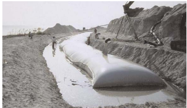
Φωτογραφία 23. Αντιδιαβρωτική προστασία ακτής με γεωσωλήνες. Photograph 23. Coastal erosion protection using geotubes (Ten Cate Nicolon).
