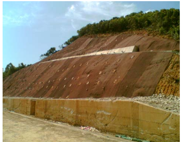
Φωτογραφία 15. Εφαρμογή σε κατολισθημένο πρανές στη Ναύπακτο τρισδιάστατου γεωσυνθετικού πλέγματος συνδυασμένου βιομηχανικά με χαλύβδινο δομικό πλέγμα (τύπου Mac-Mat® - Maccafferri)
