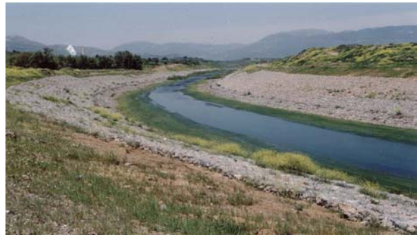
Φωτογραφία 18. Αντιδιαβρωτική προστασία κοίτης Αλφειού ποταμού με λιθοπληρωμένα συρματοκιβώτια Photograph 18. Erosion control measures along Alfios river banks using gabions.
