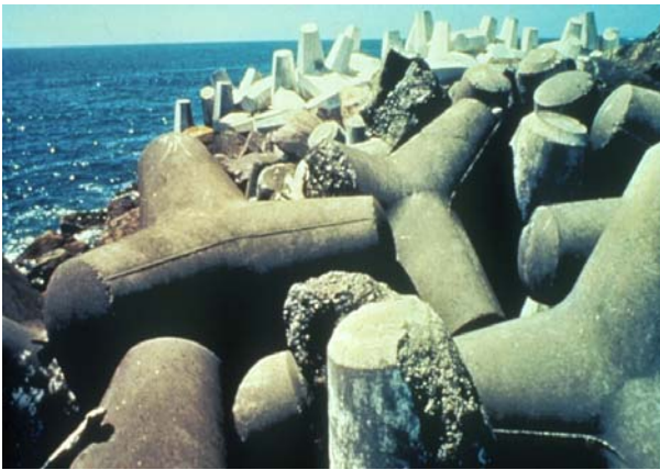
Φωτογραφία 20. Μόνιμη αντιδιαβρωτική προστασία ακτογραμμής με χρήση προκατασκευασμένων τεμαχίων σκυροδέματος Photograph 20. Permanent erosion control coastal measures using pre-cast concrete blocks.
