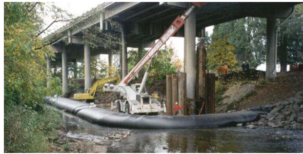
Φωτογραφία 28. Επισκευή βάθρων γέφυρας με χρήση γεωσωλήνων με νερό για την εκτροπή της ροής. Photograph 28. Bridge footing repair using water filled geotubes for flow diversion (Water Structures Unlimited)
