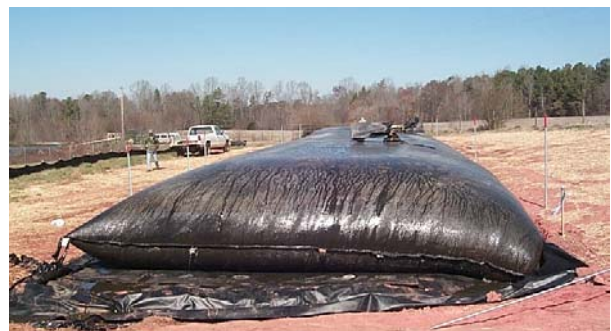
Φωτογραφία 26. Αφυδάτωση και αποθήκευση λυματολάσπης σε γεωσωλήνα. Photograph 26. Dewatering and sludge solid containment within a geotube.
