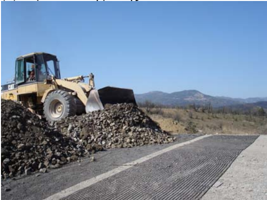
(γ) Επικάλυψη γεωπλεγμάτων με αδρανή
