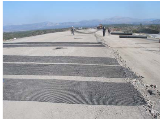
(β) Προετοιμασία διατομών δοκιμ/κού επιχώματος
